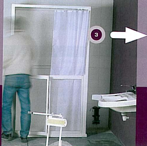
Installation de la cabine
