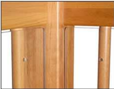
Un vitrage intérieur ou extérieur des barreaux de grille p. des vitres acryliques dévissées, avec des bords polis.
