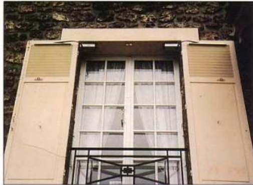
Installation en position haute (avant peinture)
